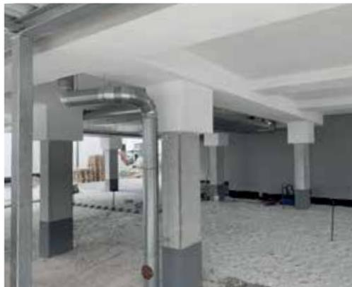
links: Stützenlösung ausgeführt mit Schöck Sconnex® Typ P.
