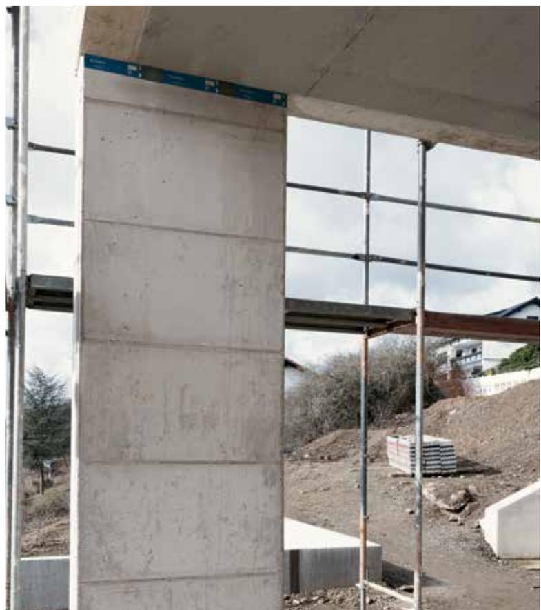
Schöck Sconnex® ermöglicht schlanke Wandvorlage in Sichtbetonoptik bei nachhaltig gelöster Wärmebrücke.
