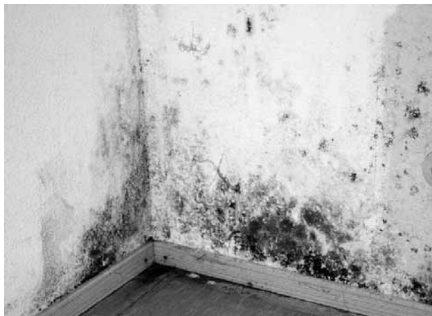
Beispiele für Schimmelpilzbefall im Wärmebrückenbereich.
