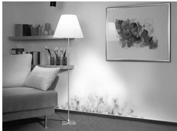
Beispiele für Schimmelpilzbefall im Wärmebrückenbereich.
