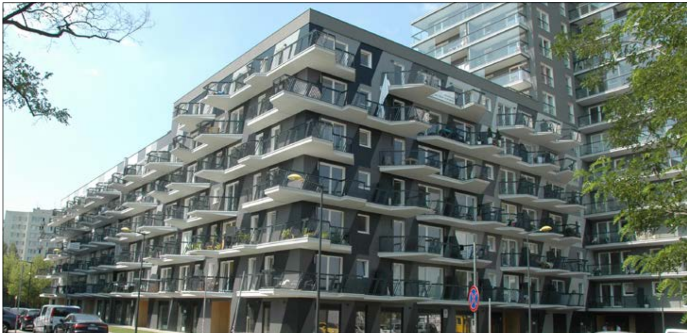
Kamion Cross, Warszawa: balkony monolityczne, z okładziną z płyt i stalową balustradą
