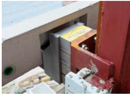
Ilustr. 1: Isokorb® z płytą czołową i tącznikami, przyspawany do podpory elewacyjnej
