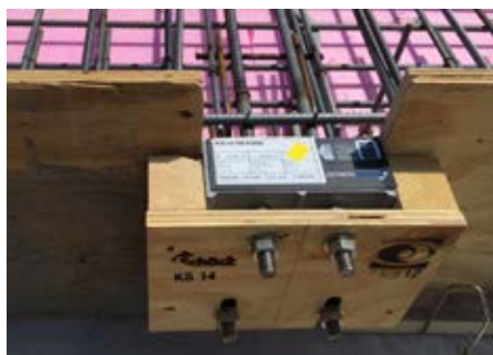
Ilustr. 1: Poziomowanie Isokorb® i mocowanie przy użyciu szablonu montażowego
