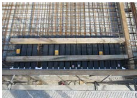
Ilustr. 1: Wbudowanie elementu stropowego i brzegowego w zbrojenie, zabetonowanie stropu i wiązanie betonu
