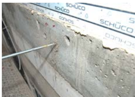
Ilustr. 1: Wykonanie otworów w stropie i ich czyszczenie
