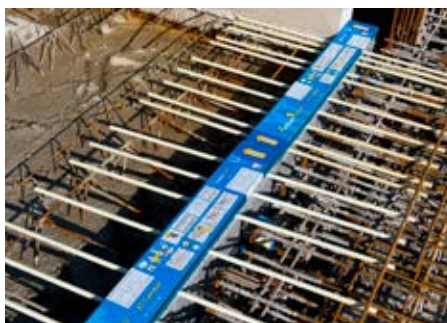
Ilustr. 1: Umieszczanie Isokorb® w zbrojeniu
