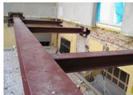
Ilustr. 2: Oddzielona termicznie konstrukcja nośna nowego balkonu
