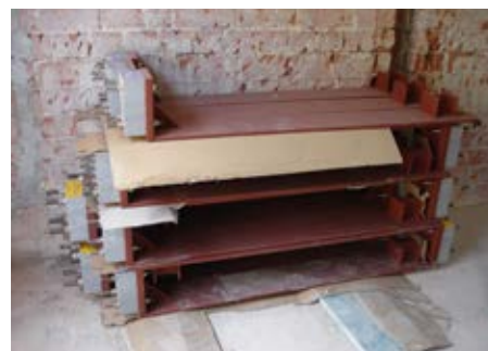
Ilustr. 2: Elementy do montażu przy użyciu Isokorb® T typu S
