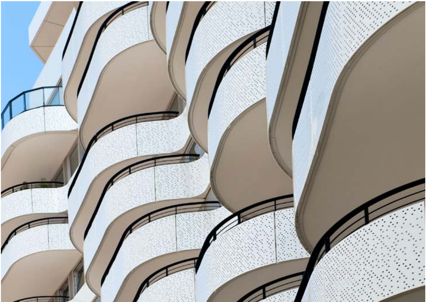
Ilustr. 5: FLOW Tower w Kolonii, przebudowa biurowca BDI, JSWD Architekten
