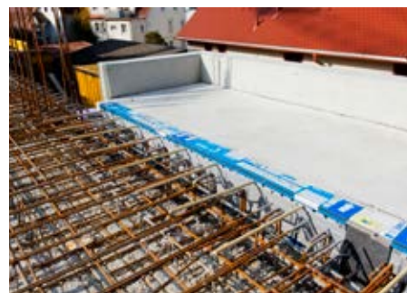
Ilustr. 2: Montaż prefabrykatu w stropie
