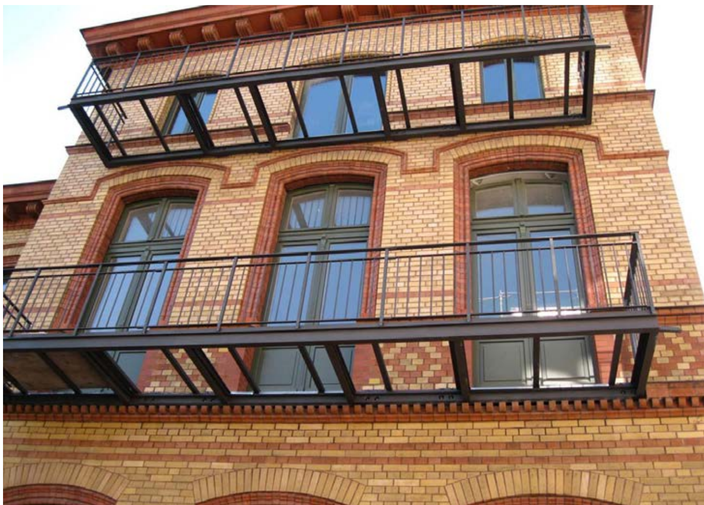
Ilustr. 3: Oddzielony termicznie balkon stalowy na elewacji historycznego budynku
