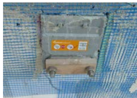
Ilustr. 2: Montaż izolacji termicznej i tynkowanie
