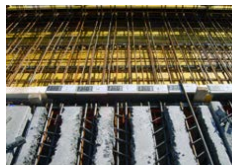
Ilustr. 2: Górne kieszenie do zalewania w stropach z płyt kanałowych, ze zbrojeniem na zakład
