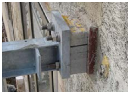
Ilustr. 1: Nowe połączenie balkonu przy użyciu Isokorb® T typu S
