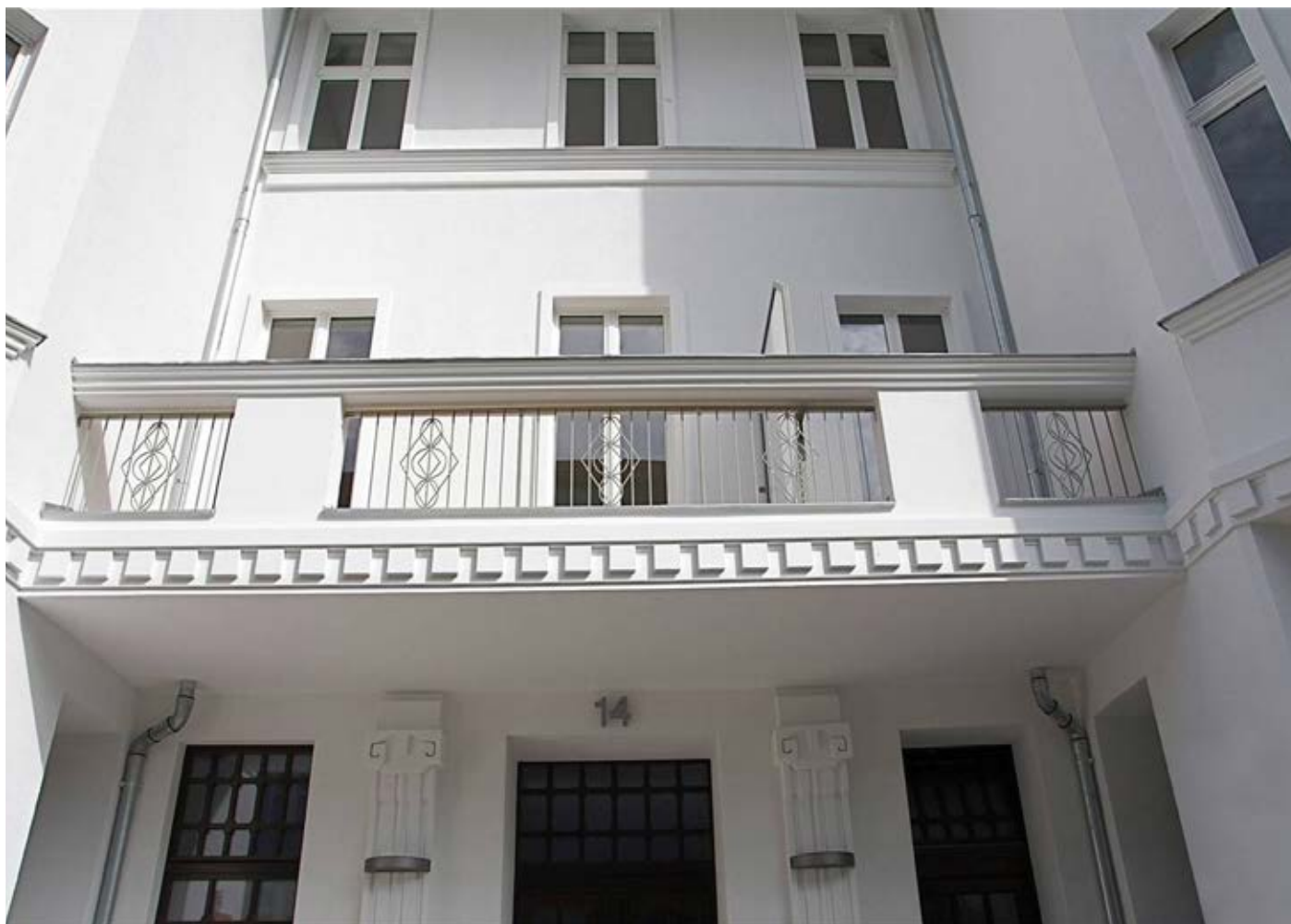
Ilustr. 3: Balkon zmodernizowany i oddzielony termicznie zgodnie z przepisami o ochronie zabytków
