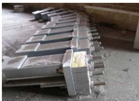
Ilustr. 1: Nowe połączenie balkonu przy użyciu Isokorb® T typu S
