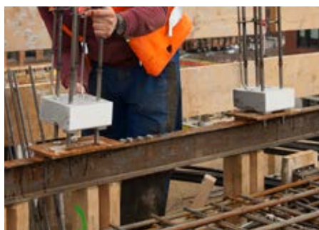
Ilustr. 1: Mocowanie Isokorb® do szablony stalowego
