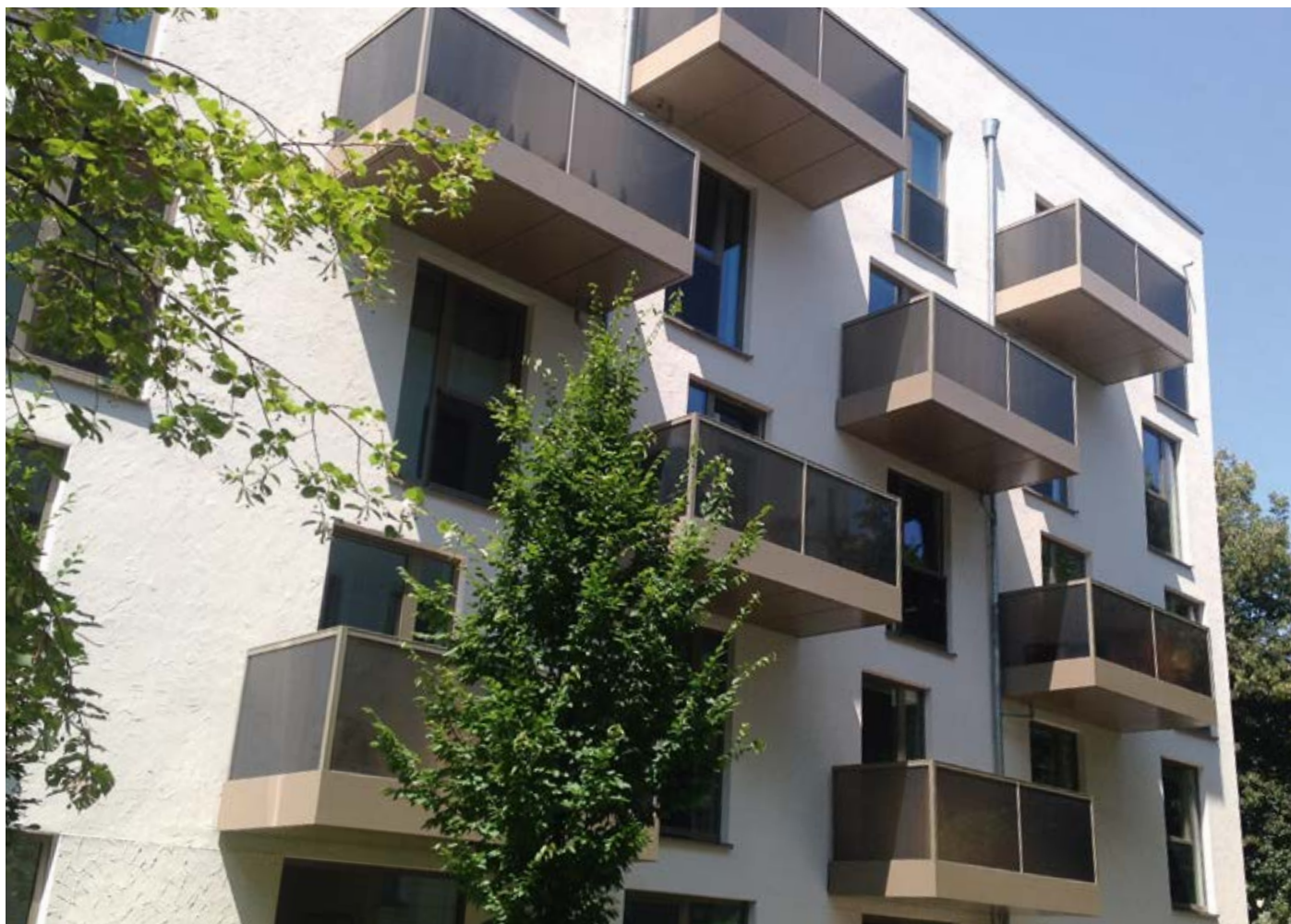
Ilustr. 3: Zmodernizowany budynek z balkonami z oddzieleniem termicznym
