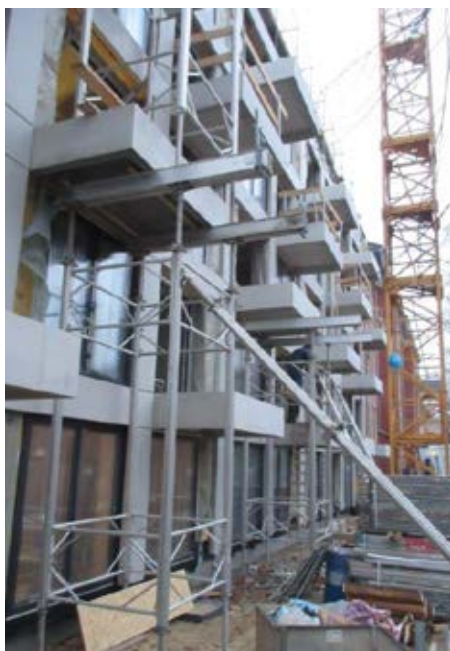
Ilustr. 4: Umieszczenie, wyrównanie, podparcie balkonu prefabrykowanego
