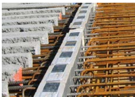
Ilustr. 1: Isokorb® wbudowany w zbrojenie
