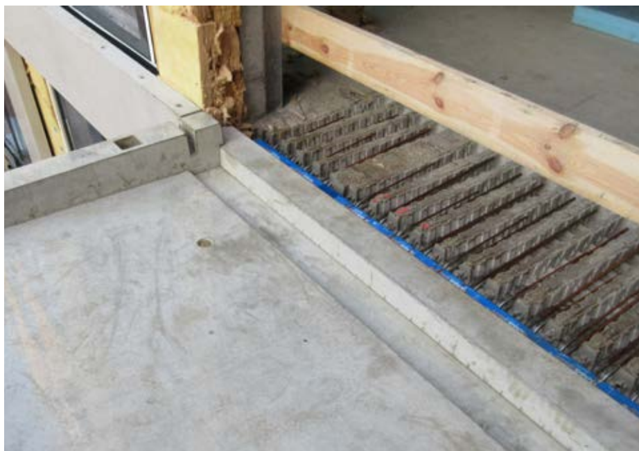
Ilustr. 5: Wypełnienie zagłębień zaprawą zalewową, pozostawienie do związania betonu na 48 godzin
