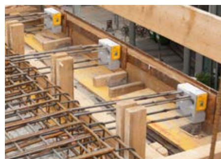
Ilustr. 2: Wsuniecie w zbrojenie stropu, stalowy szablon zapewnia dokładny montaż
