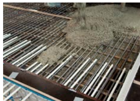
Ilustr. 2: Betonowanie stropu i płyty balkonowej
