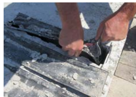
Ilustr. 2: Usunięcie elementów stropowych i brzegowych po związaniu betonu
