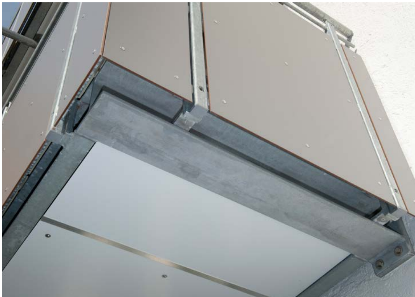
Ilustr. 3: Przykręcanie prefabrykowanego balkonu stalowego do łącznika Isokorb®
