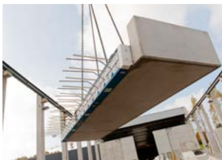
Ilustr. 1: Dostawa prefabrykatu na budowę
