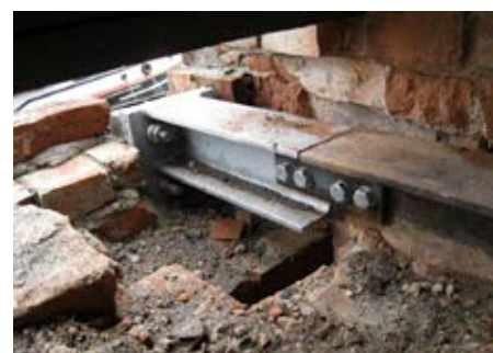
Ilustr. 2: Nowe połączenie balkonu do istniejącego dźwigara stalowego
