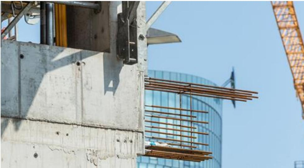
*Mit einem Durchmesser von 20 mm bei den Zug- und Druckstäben sowie 14 mm bei den Querkraftstäben zählen die eingesetzten Isokorb Typen zu den stärksten von Schöck. Foto: Fotostudio Huger, Abdruck honorarfrei.*
