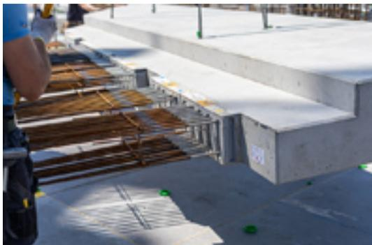
*Der Einbau des Isokorb in die Balkonplatten erfolgte bereits im Fertigteilwerk.*
