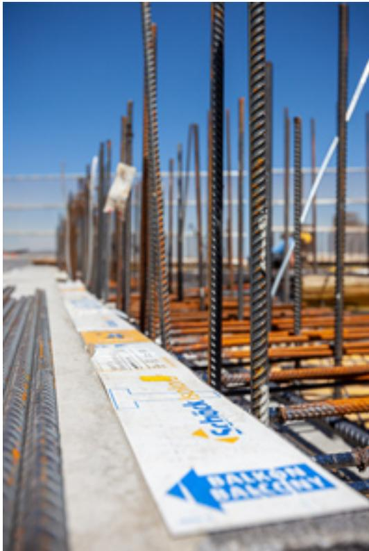
*Verschiedene Typen des tragenden Wärmedämmelements Schöck Isokorb lösten statische Herausforderungen im Wiener Projekt Q-Tower Wien.
