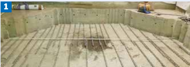
1 Une cavité octogonale d'un diamètre de 5 400 mm et d'une profondeur de 600 mm a été conçue, avec des perçages sur les côtés pour installer les nouveaux ancres d'armatures Schöck Combar.
