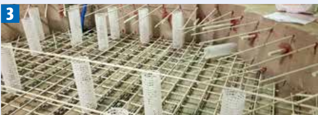
3 Une fois les ancres d'armatures Schöck Combar posés, les écarteurs simplifient le montage du treillis d'armature supérieur.
