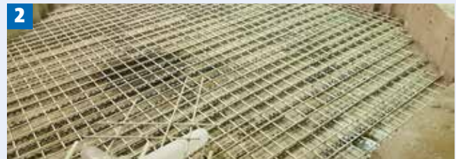
2 Le nouveau renforcement inférieur de la dalle comprend 72 barres Schöck Combar en fibres de verre, montées en treillis de 12 mm de diamètre.
