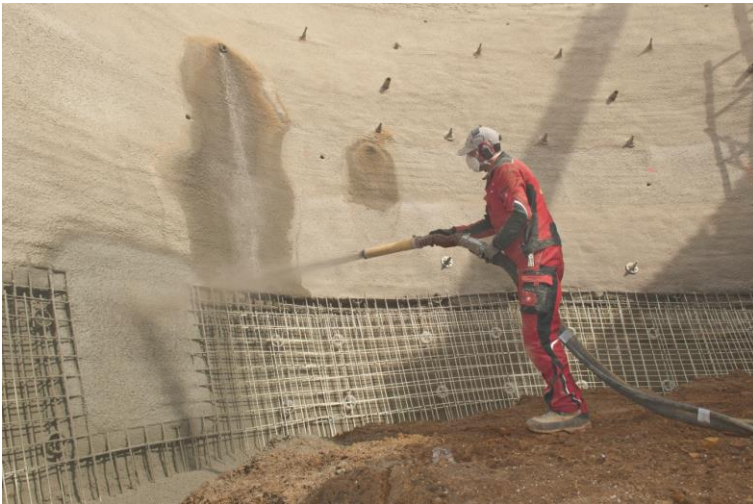
Spritzbetoneinbau in die mit Schöck Combar bewehrte Baugrubenwand. Foto: Schöck Bauteile GmbH, Abdruck honorarfrei.
