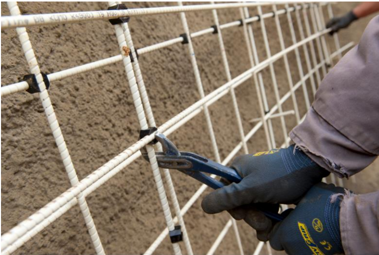
Verbindung der Spritzbetonbewehrung aus Schöck Combar mit stahlfreien Clips. Foto: Schöck Bauteile GmbH, Abdruck honorarfrei.
