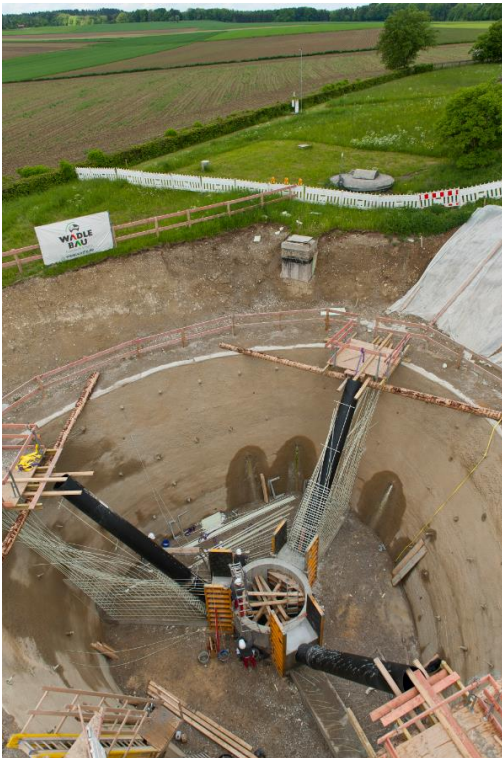
Luftbild der Baugrube mit Zentralschacht und Messrohren in den Wänden des Tetraeders. Foto: Schöck Bauteile GmbH, Abdruck honorarfrei.
