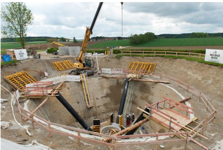
Einbau der Glasfaserbewehrung Schöck Combar für die Flügelwände des Tetraeders. Foto: Schöck Bauteile GmbH, Abdruck honorarfrei.
