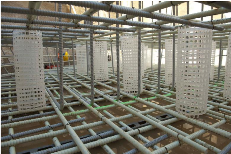
Bewehrungsdetail der Bodenplatte: Stahlfreie Abstandhalterrohre zwischen zwei Bewehrungslagen aus dem Glasfaserstab Schöck Combar. Foto: Schöck Bauteile GmbH, Abdruck honorarfrei.
