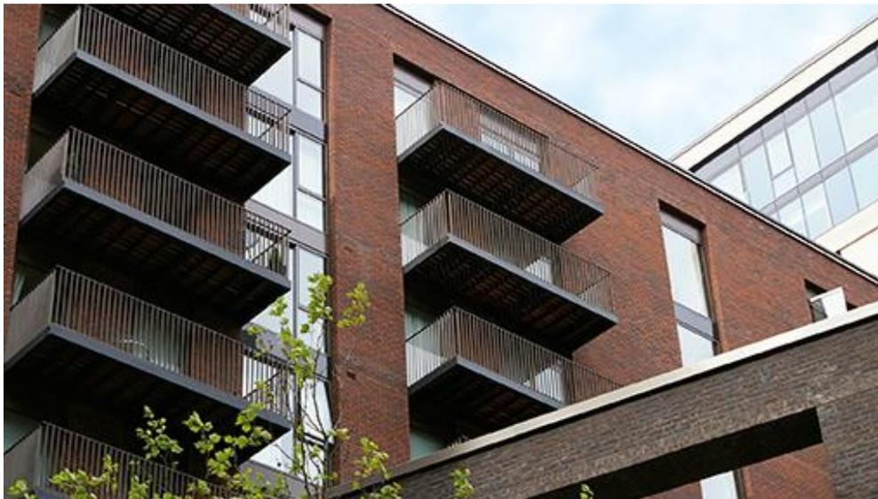
*Die Stahlbalkone mit Blick auf den Innenhof wurden mit dem Isokorb Typ KS für Beton-Stahl-Konstruktionen thermisch getrennt. Foto: Schöck Bauteile GmbH, Abdruck honorarfrei.*
