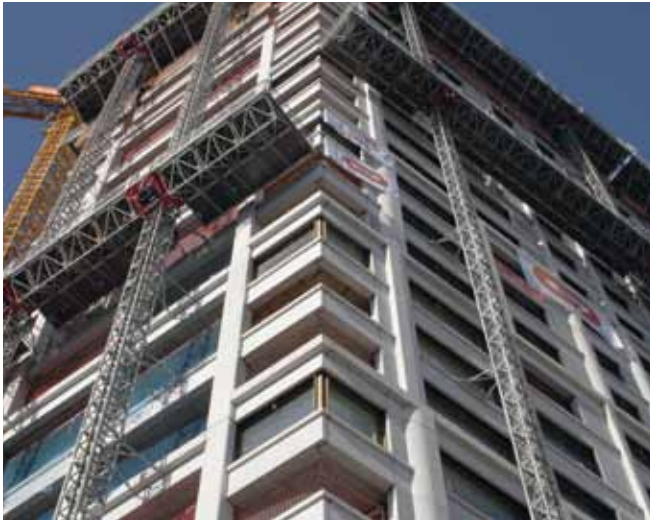
Die 950 Betonfertigteile sehen von weitem alle identisch aus, variieren im Detail aber stark.
