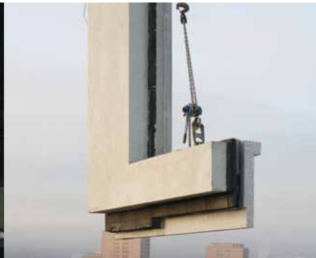
Die Elemente wurden per Kran und von nur drei Monteuren individuell versetzt.
