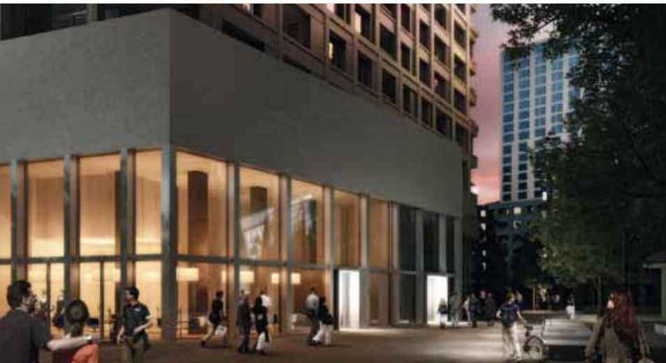
Die Fassade besteht aus 950 Sandwich-Elementen mit sandgestrahlter äusserer Oberfläche.
