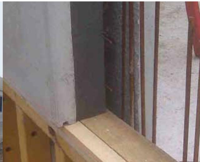
Die Fassade besteht aus relativ dünnen aber hoch dämmenden Stahlbetonsandwichwänden.
