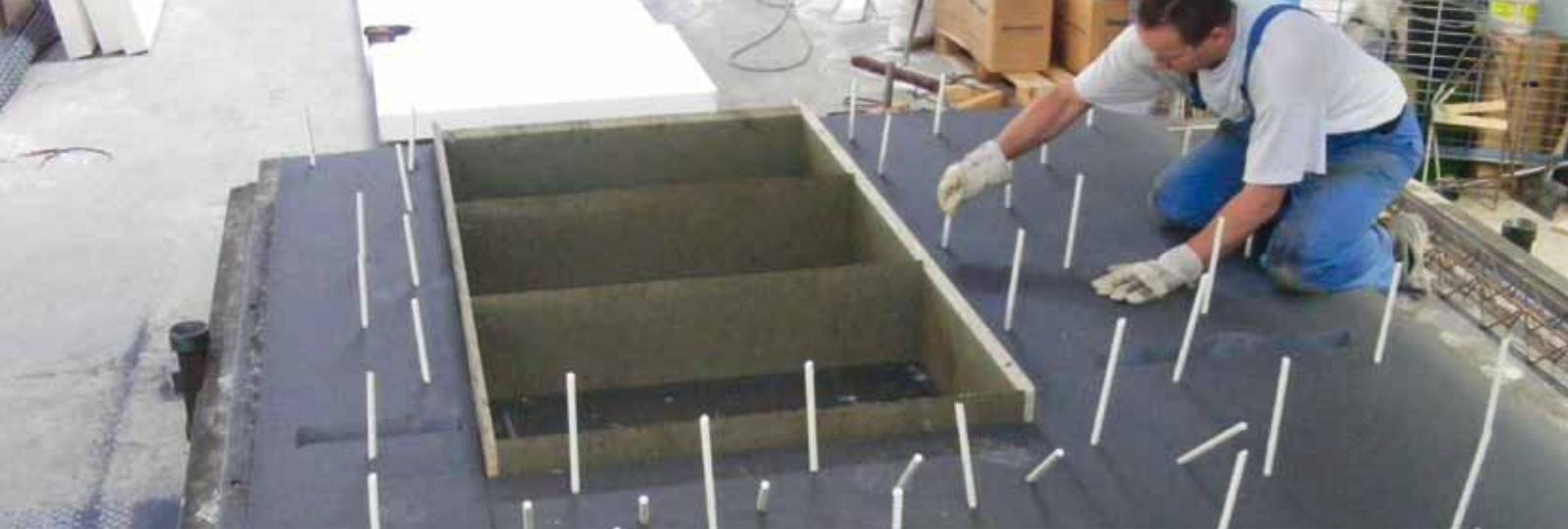
Durch die vorgebohrten Dämmplatten wurden die Thermoanker mit einem kreuzweisen Abstand von 40 Zentimetern in die frisch betonierte Wand gesteckt.
