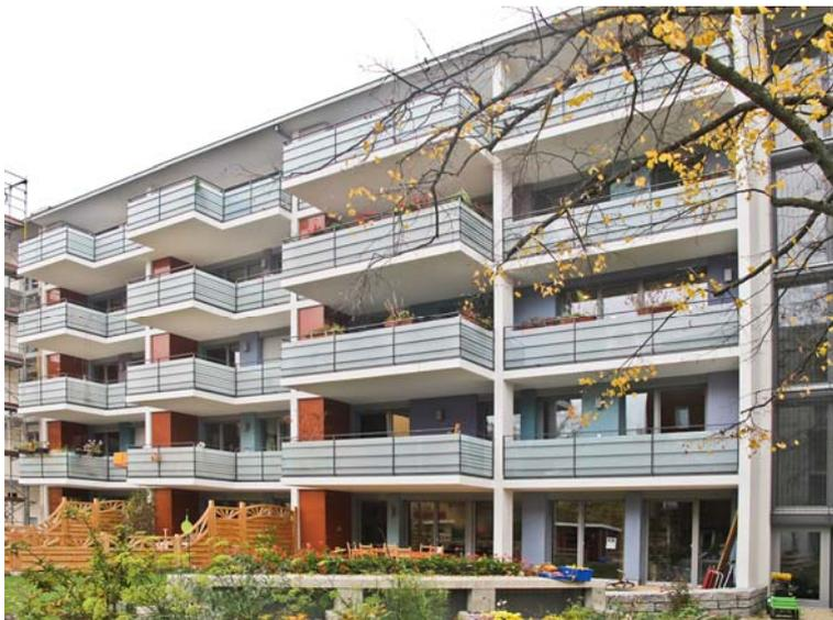
*Alle Wohnungen werden straßenseitig über einen natürlich belüfteten Laubengang barrierefrei erschlossen. Gartenseitig verfügen sie zudem über großzügige Balkone. Die tragende Verbindung mit dem Gebäudekern bildet der Isokorb von Schöck.*
