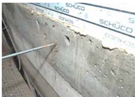
Abb. 1: Bohrungen in Decke herstellen und reinigen
