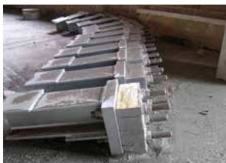
Abb. 1: Neuer Balkonanschluss mit Isokorb® T Typ S
