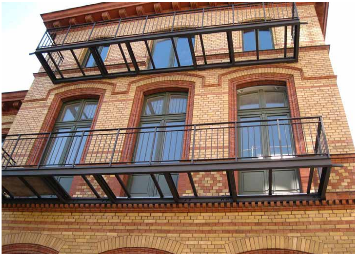
Abb. 3: Thermisch getrennter Stahlbalkon an historischer Fassade
