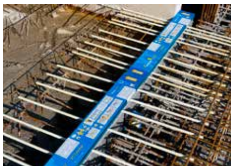
Abb. 1: Isokorb® in Bewehrung einsetzen
