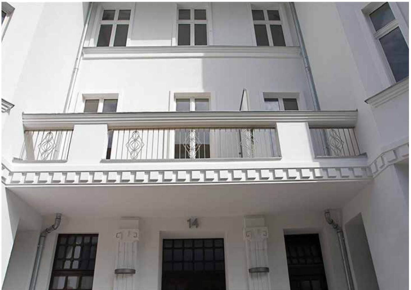
Abb. 3: Denkmalgerecht sanierter und thermisch getrennter Balkon
