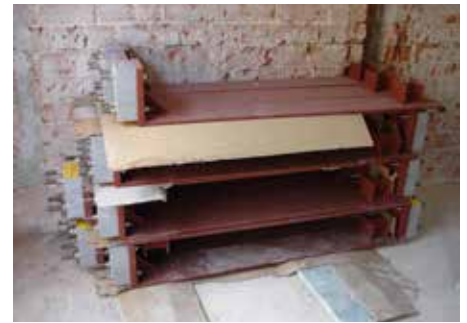
Abb. 2: Einbauteile mit Isokorb® T Typ S
