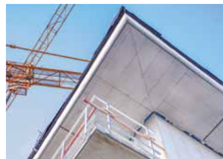
Abb. 2: Untersicht von freiauskragendem Vordach-Eck mit Dehnfuge
