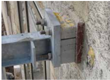
Abb. 1: Neuer Balkonanschluss mit Isokorb® T Typ S
