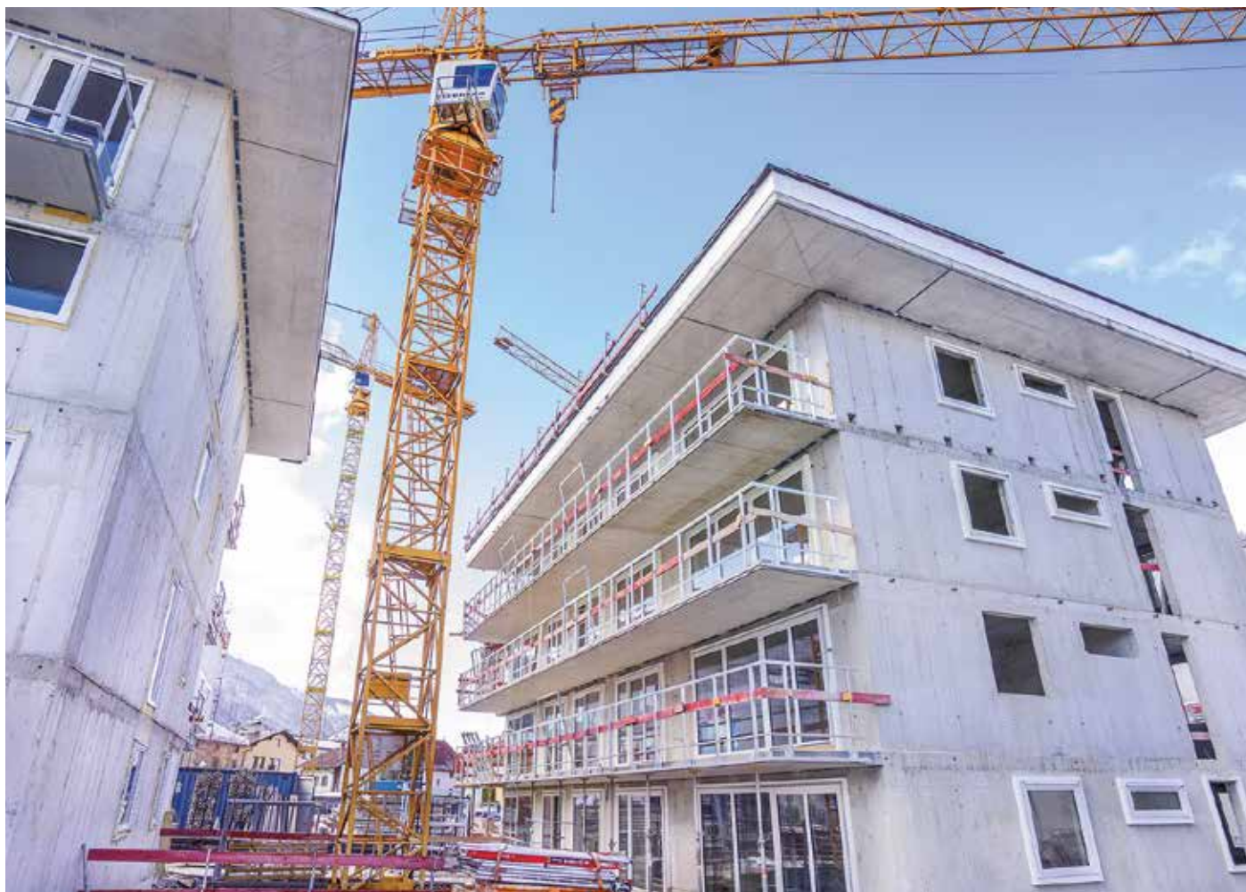
Abb. 3: Ausgeschaltete Balkonplatten nach Erreichen der Beton-Endfestigkeit
