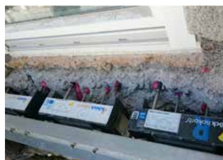
Abb. 2: Isokorb® einkleben und Vergusstasche kraftschlüssig verfüllen
