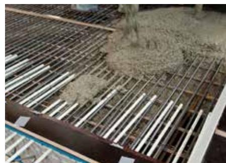
Abb.2: Decke und Balkonplatte betonieren
