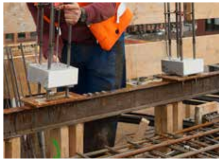
Abb. 1: Isokorb® auf Stahlschablone fixieren
