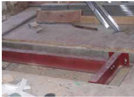
Abb. 1: Rückverankerung des Balkons in die Holzbalkendecke
