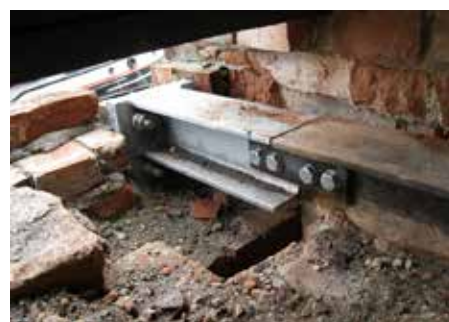
Abb. 2: Neuer Balkonanschluss an bestehendem Stahlträger
