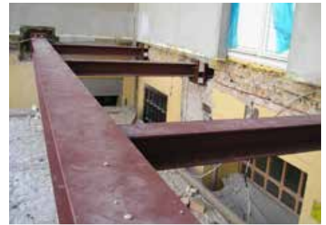
Abb. 2: Thermisch getrenntes Tragwerk des neuen Balkons
