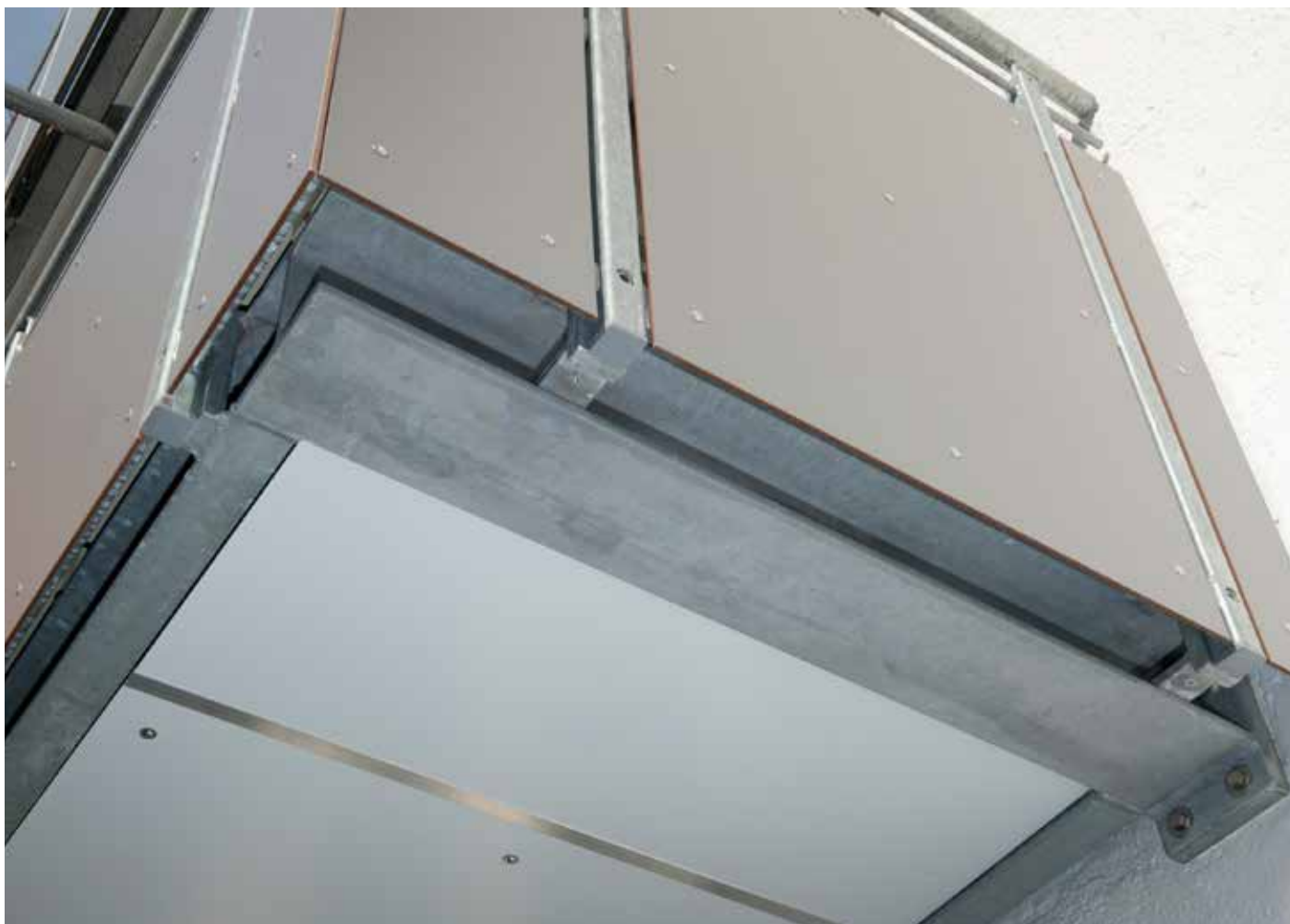
Abb. 3: Vorgefertigten Stahlbalkon mit Isokorb® verschrauben
