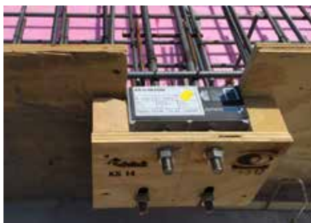
Abb. 1: Isokorb® ausrichten und fixieren mittels Einbauschablone
