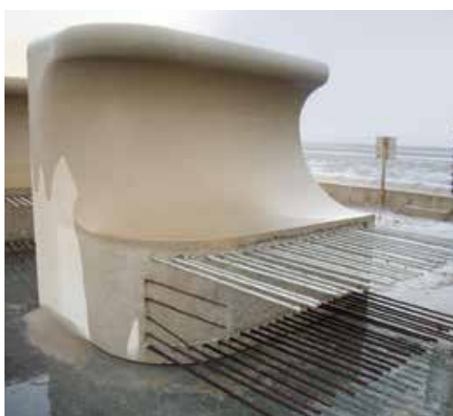
Eléments préfabriqués le long du quai à Blackpool en Grande-Bretagne.
