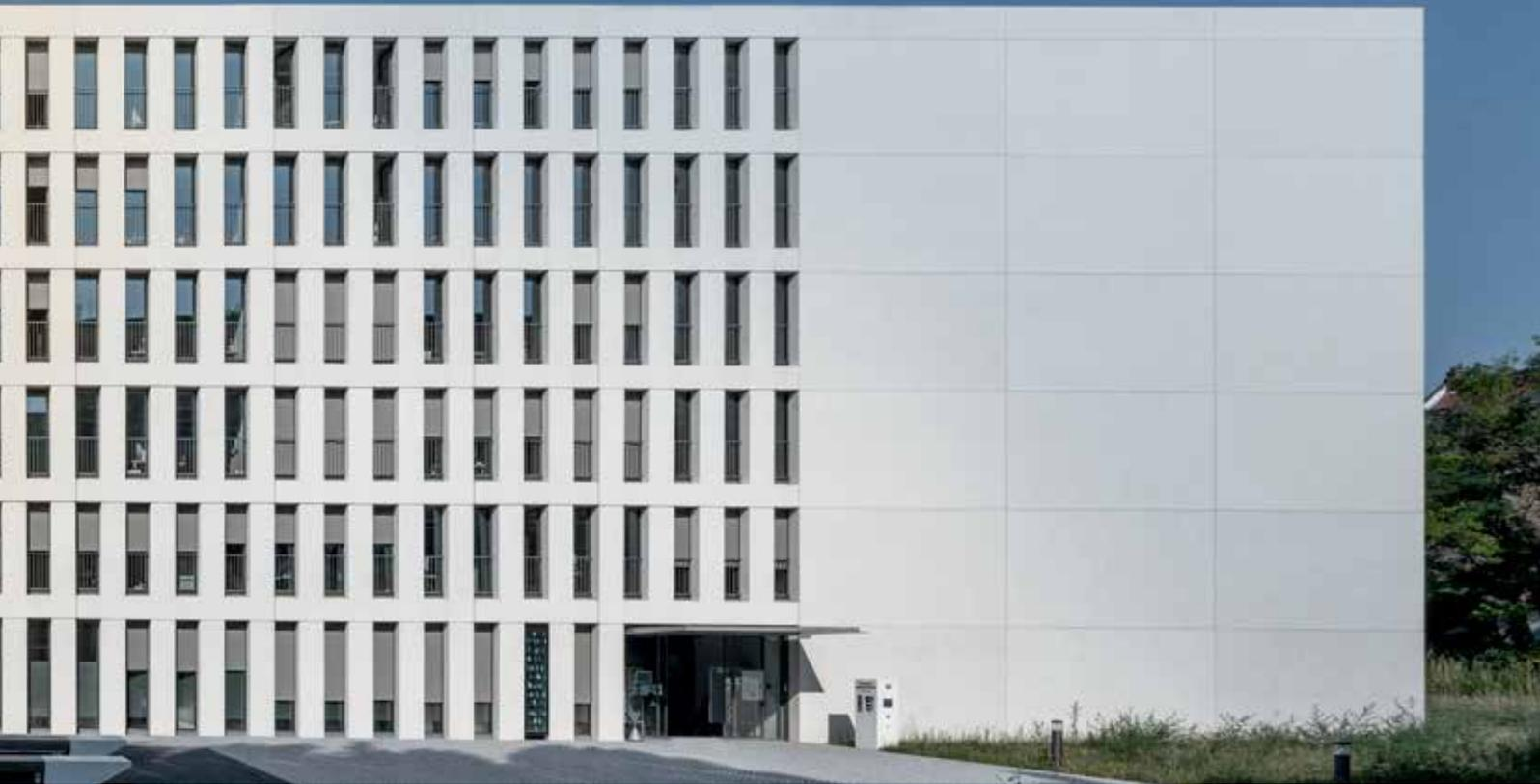
Todo los elementos de fachada se arenaron en la fábrica de prefabricados
