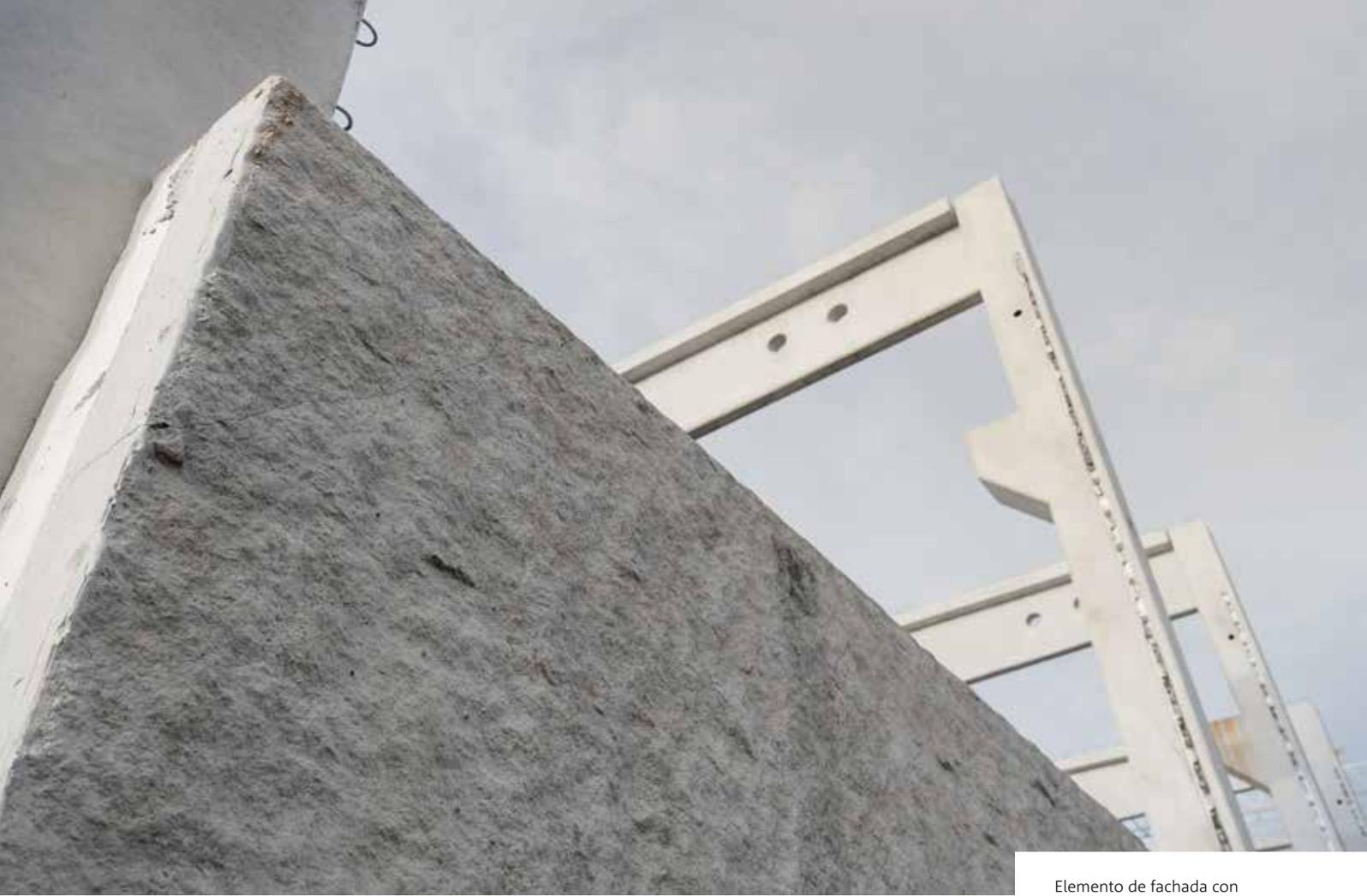
Elemento de fachada con capa portante de hormigón, aislamiento de poliestireno expandido y paramento de hormigón
