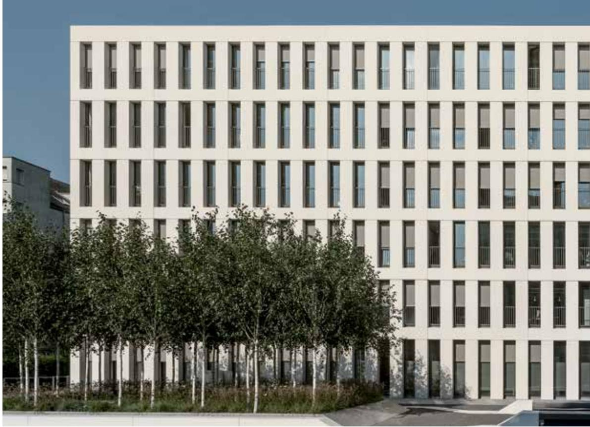
La fachada se ha construido con más de 350 prefabricados de hormigón
