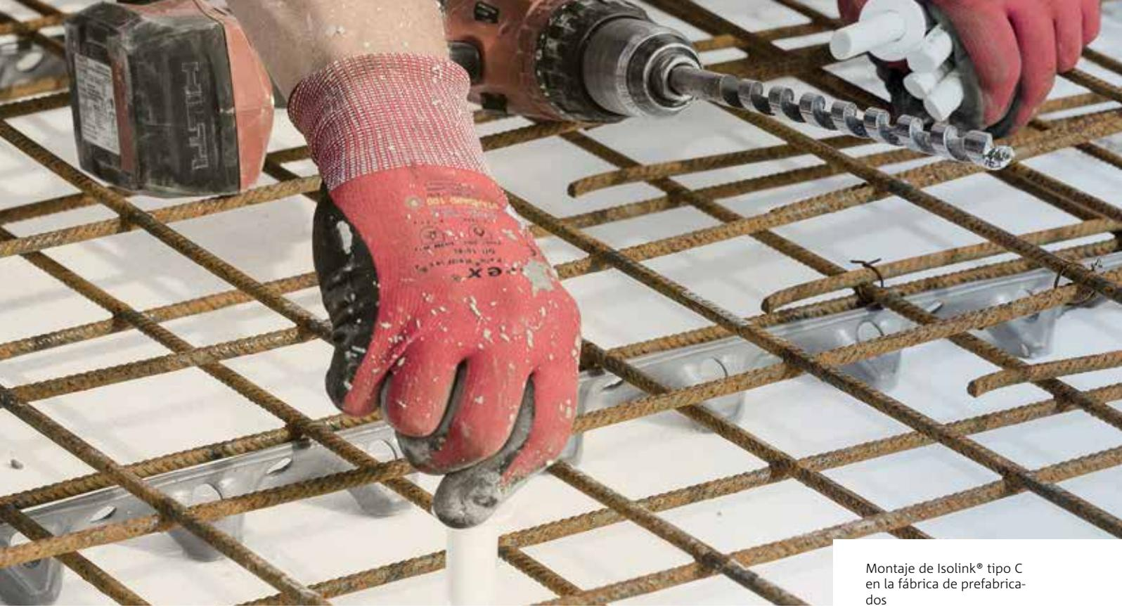
Montaje de Isolink® tipo C en la fábrica de prefabricados
