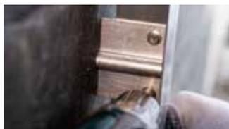
A continuación, se desenrosca la placa adaptadora y la subestructura puede atornillarse o remacharse.
