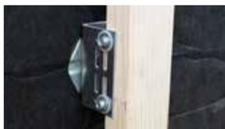
La subestructura de madera se fija en los adaptadores.
