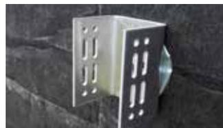
Tras la colocación de las placas aislantes, se atornillan soportes aislantes y adaptadores VECO® Timber de GIP en los anclajes de fachada.
