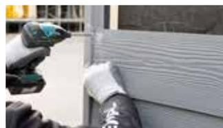
En la subestructura revestida con lámina EPDM se atornillan los paneles de fachada de Cedral.
