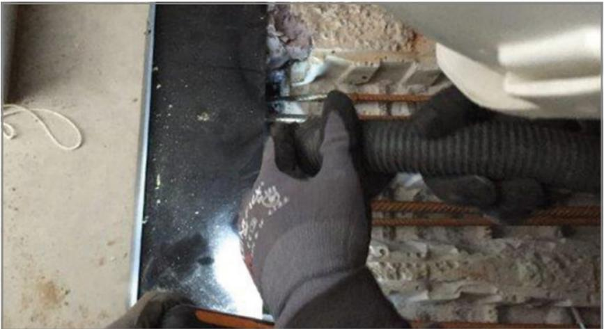
Fig. 52: étanchéifier la zone de coulage et éliminer le matériau en excès
