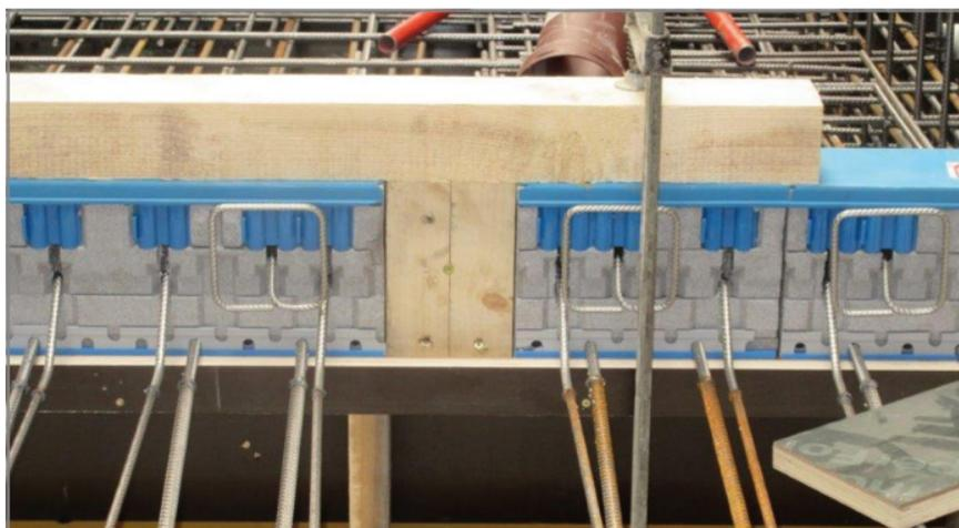
Fig. 17: évidement pour ancre de levage
