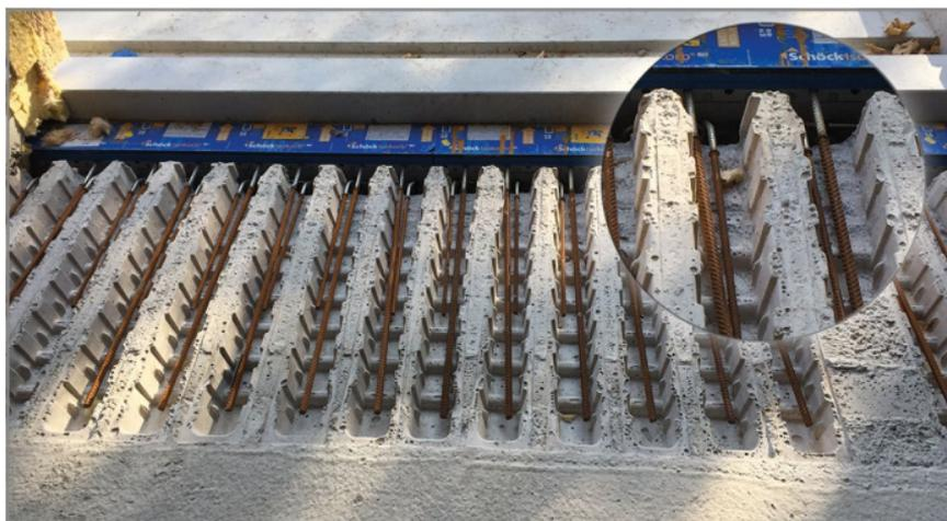
Fig. 62: dalles préfabriquées placées proprement dans les évidements de la dalle ; vue depuis la dalle
