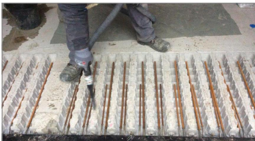
Fig. 60: introduire l'armature de traction de l'élément Schöck Isokorb® dans les évidements
