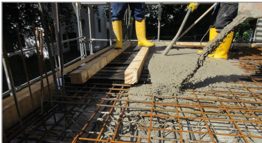
Fig. 34: coulage du mortier au niveau de l'élément de dalle Schöck IDock®
