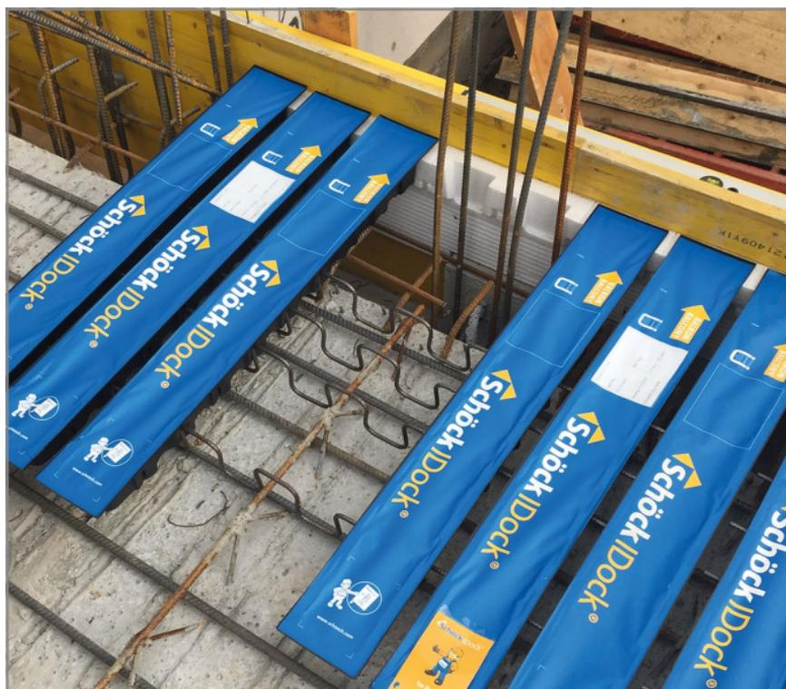
Fig. 30: amener l'élément de dalle en position et vérifier l'horizontalité
