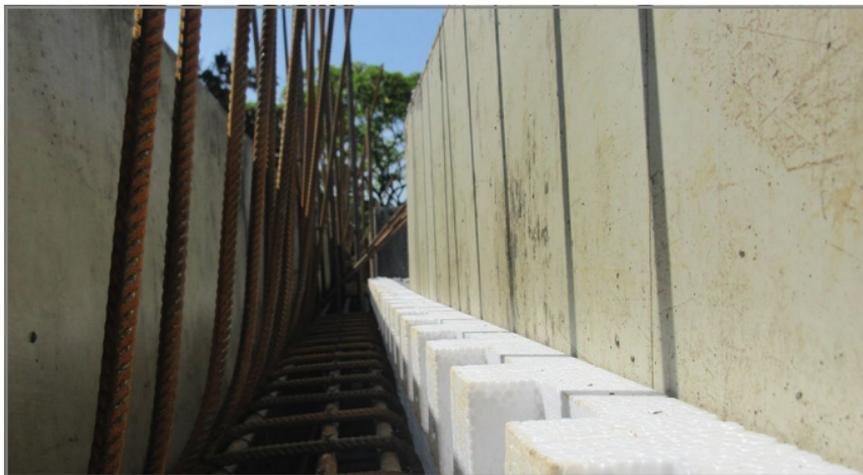
*Fig. 43: élément de bord fixé au coffrage de la paroi externe*
