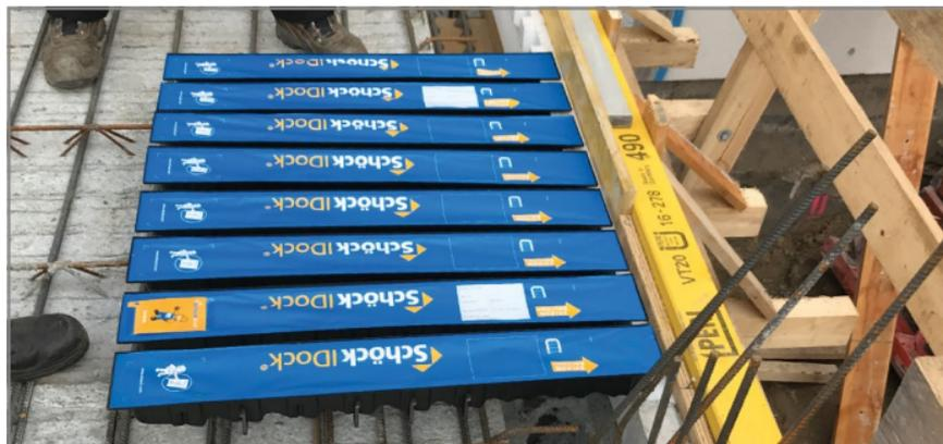
Fig. 29: placer l'élément de dalle, tirer l'armature dans le creux des éléments d'évidement vers le haut et la fixer
