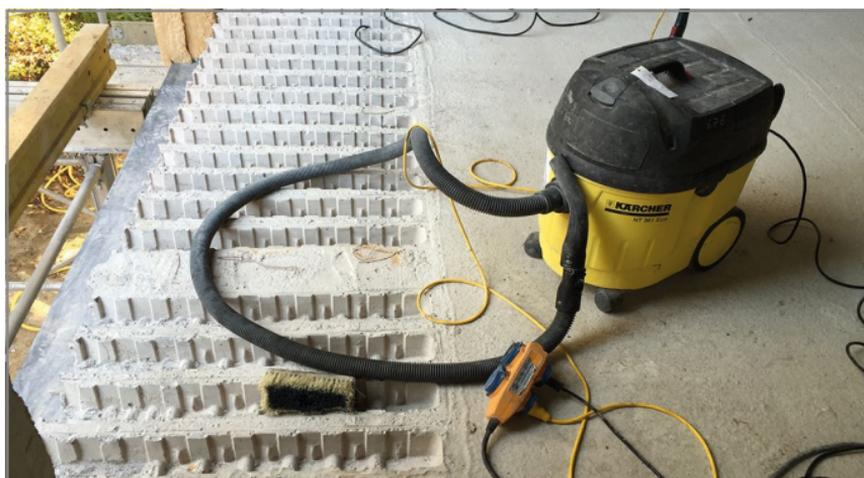
Fig. 50: L'évidement doit être nettoyé à l'aide d'un aspirateur industriel
