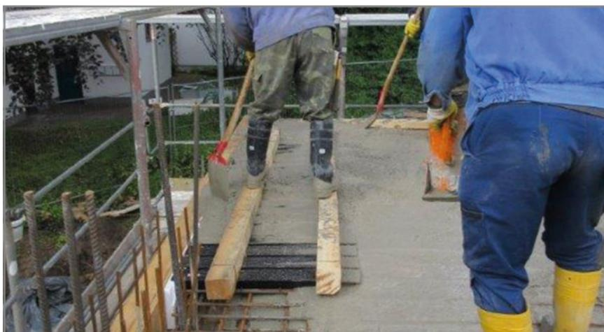
Fig. 36: évolution du coulage du mortier au niveau de l'élément de dalle
