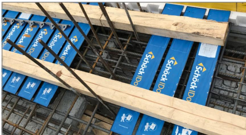
Fig. 33: dalle préparée pour couler le mortier
