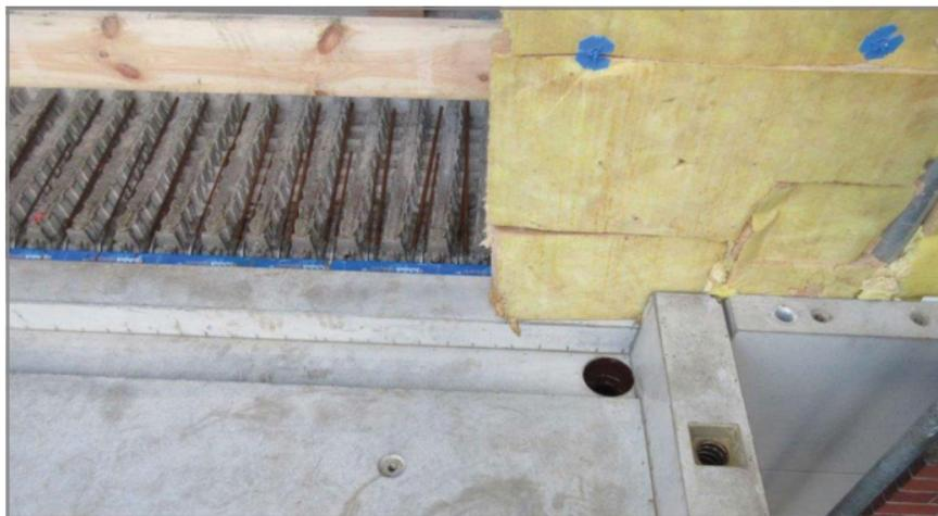
Fig. 61: dalles préfabriquées placées proprement dans les évidements de la dalle ; vue depuis le balcon
