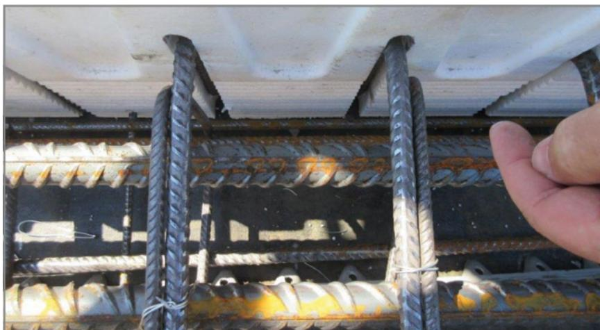
Fig. 28: placer l'armature transversale et longitudinale
