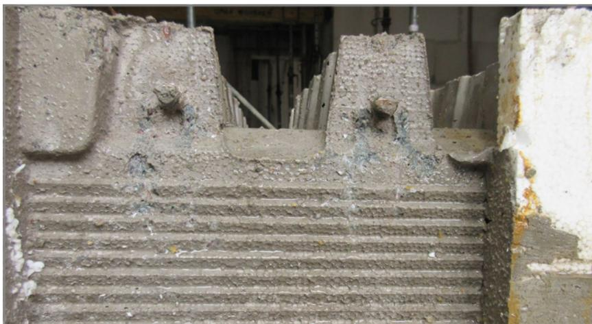
Fig. 46: dalle après l'élimination de l'élément de dalle Schöck IDock® avec l'armature de raccordement visible
