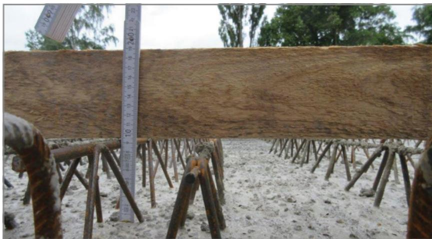
Fig. 25: respecter la hauteur des supports de grillage
