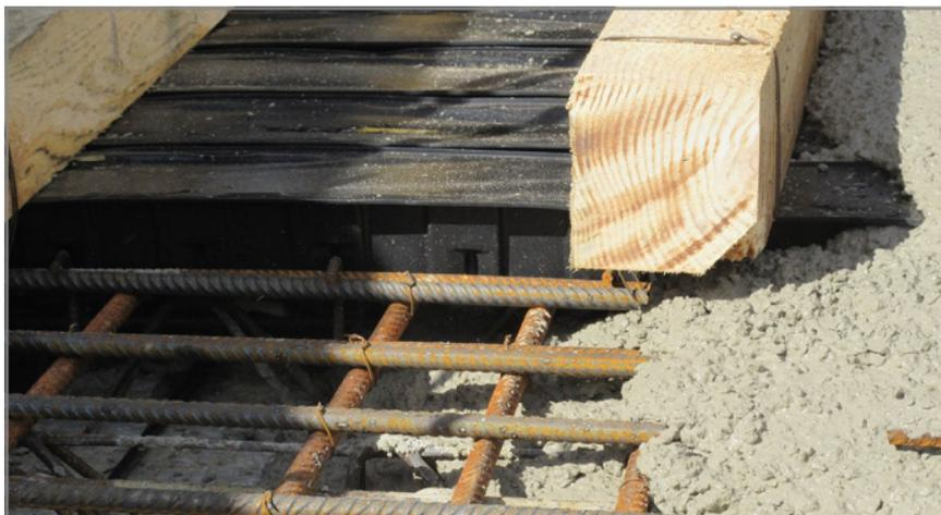
Fig. 35: Vue détaillée : coulage du mortier au niveau de l'élément de dalle Schöck IDock®
