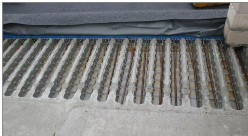
*Fig. 49: dalle après l'élimination de l'élément de dalle Schöck IDock® avec un élément Schöck Isokorb®*
