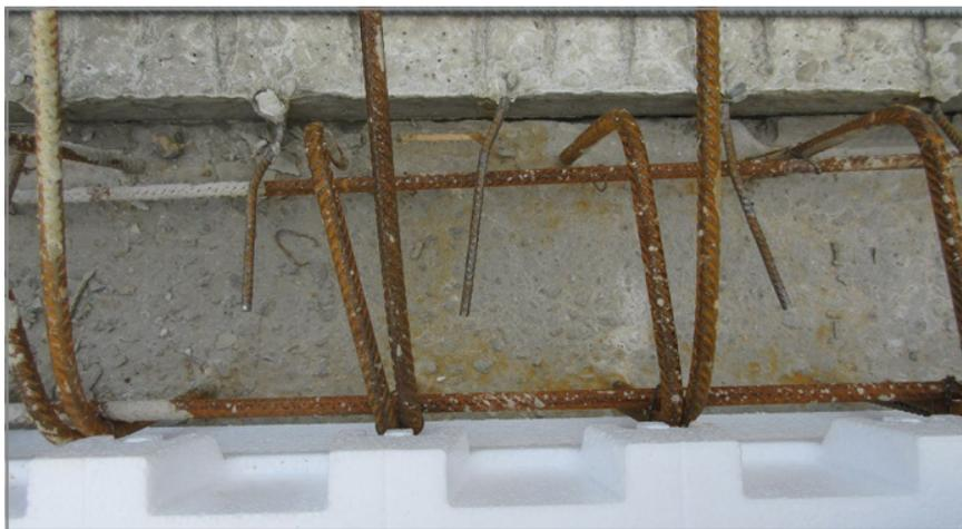
Fig. 27: grille formée par les étriers et l'élément de bord
