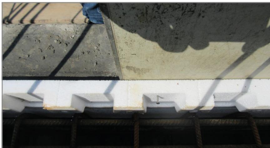
Fig. 42: Vue détaillée : fixer les éléments de bord au coffrage du béton coulé sur site
