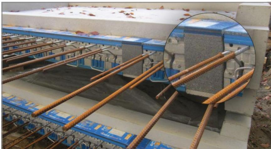
*Fig. 20: L'évidement avec ancre de levage est rempli par l'élément Schöck Isokorb® XT/T type Z après le transport*
