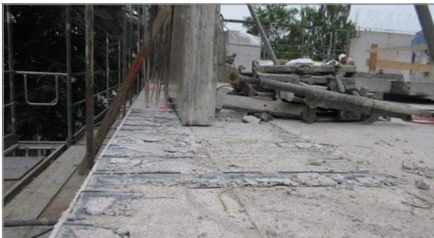
Fig. 39: coffrage pour paroi en béton coulé sur site
