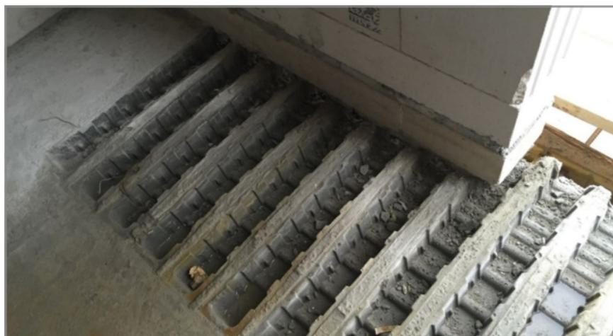
Fig. 45: maçonnerie sur les évidements décoffrés, vue détaillée
