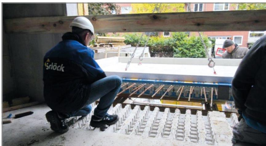
Fig. 59: placer balcon préfabriqué dans les évidements de la dalle
