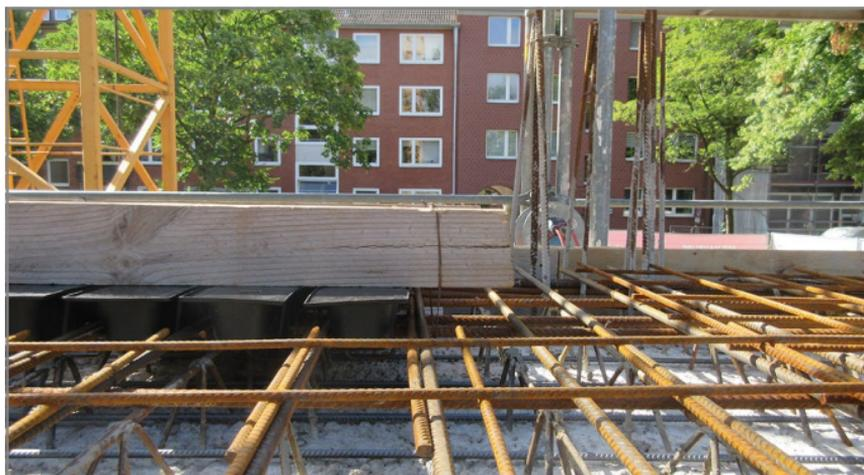
Fig. 32: vue de face : maintenir l'élément de dalle en place à l'aide de poutres ou de madriers d'échafaudage
