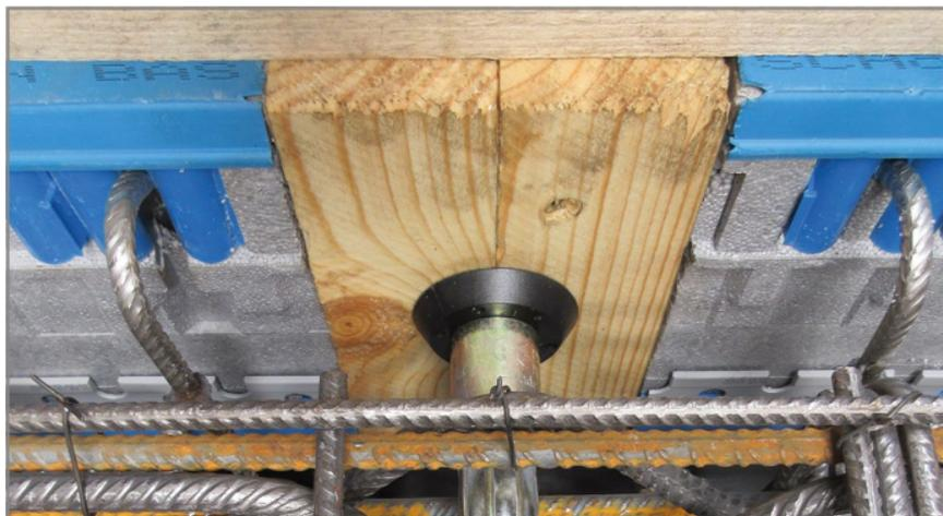
Fig. 18: Vue détaillée : évidement pour ancre de levage
