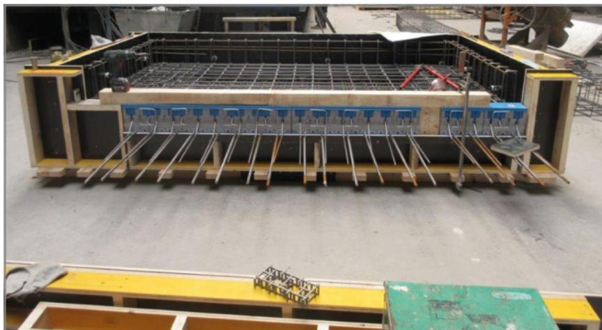
Fig. 15: coffrage, armature et élément Schöck Isokorb®
