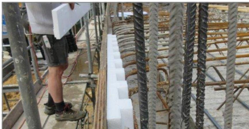
Fig. 24: couper l'élément de bord à dimension et le fixer
