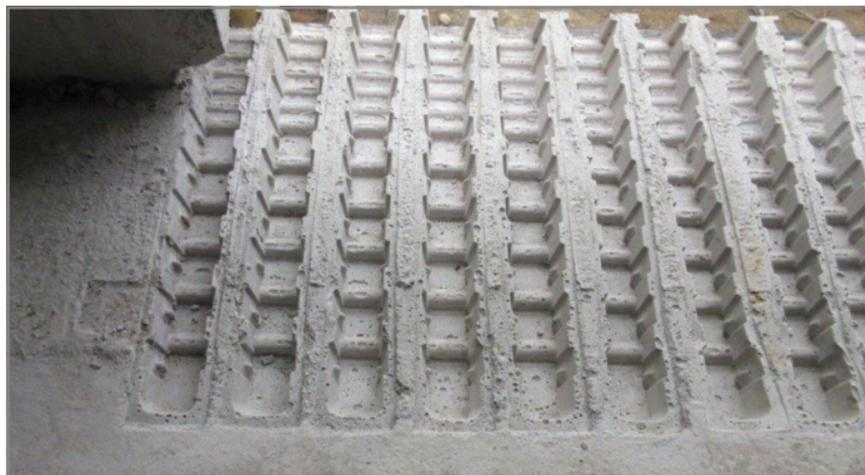
*Fig. 48: dalle après l'élimination de l'élément de dalle Schöck IDock® sans élément Schöck Isokorb®*
