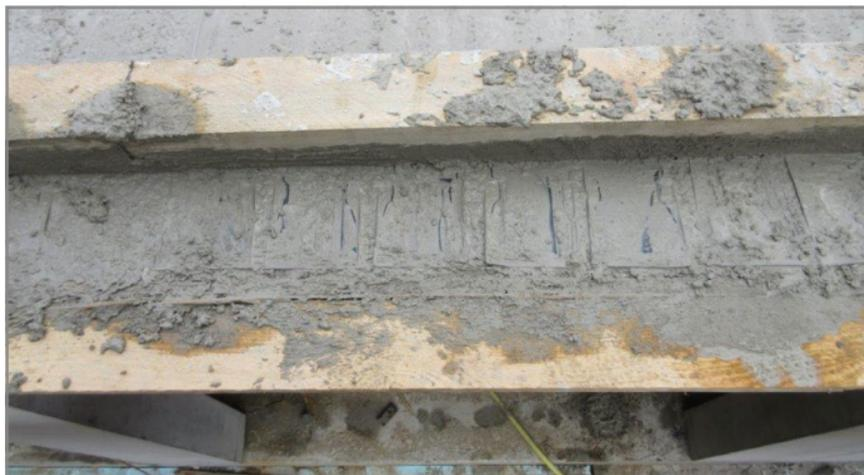
Fig. 38: éliminer le béton en excès
