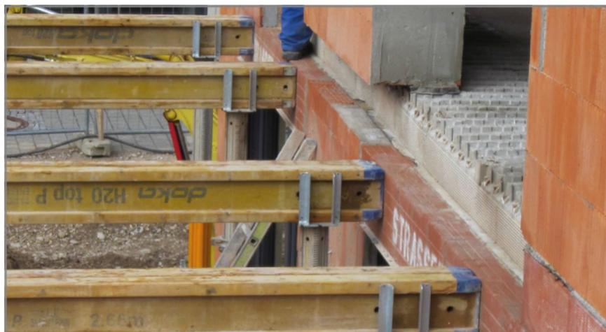
Fig. 44: maçonnerie sur les évidements décoffrés
