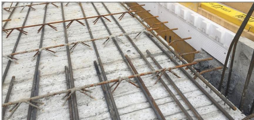
Fig. 41: fixer les éléments de bord au coffrage du béton coulé sur site
