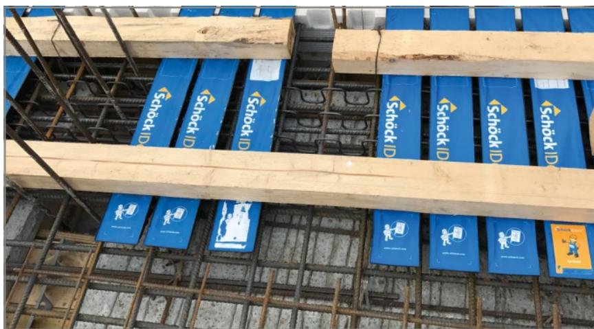
Fig. 26: vérifier la position correcte de l'armature sur chantier par la pose des éléments de dalle
