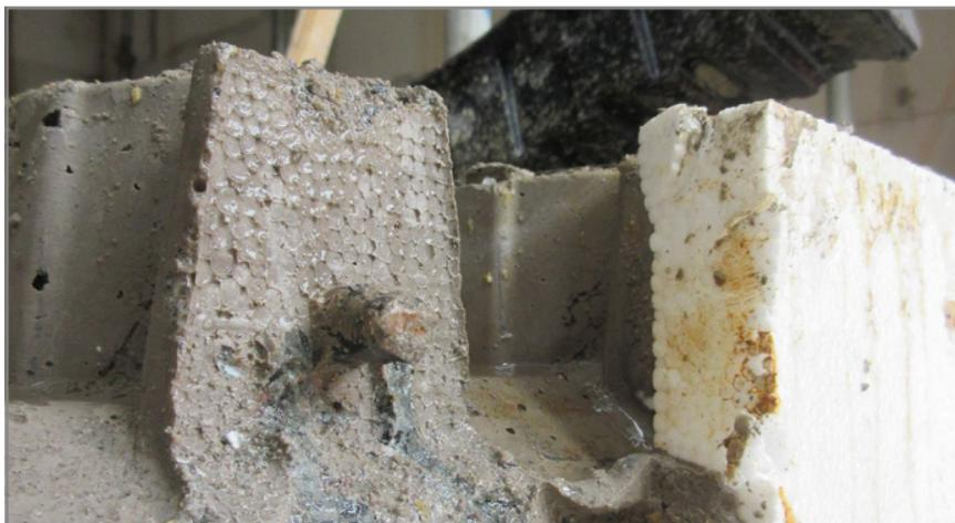
Fig. 47: Vue détaillée : dalle après l'élimination de l'élément de dalle Schöck IDock®
